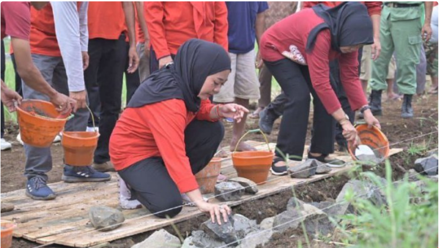
Bupati Purbalingga, Dyah Hayuning Pratiwi Letakan Batu Pertama Pembangunan Talud Irigasi di Desa Limbasari
